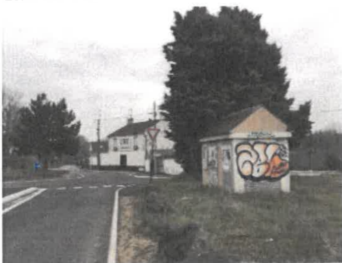
En venant de Luzarches, l'édicule technique et les conifères marquent l'arrivée sur le carrefour et cachent l'emplacement du calvaire.
